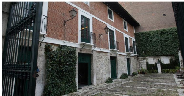
Exterior de la Casa Cervantes en Valladolid / Miriam Chacón (ICAL)
